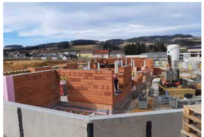
Die Bauarbeiten für den neuen Kindergarten schreiten zügig voran.
